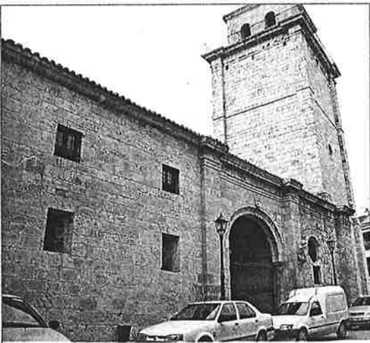
Iglesia de Santa María, en la localidad de Peñafiel.
